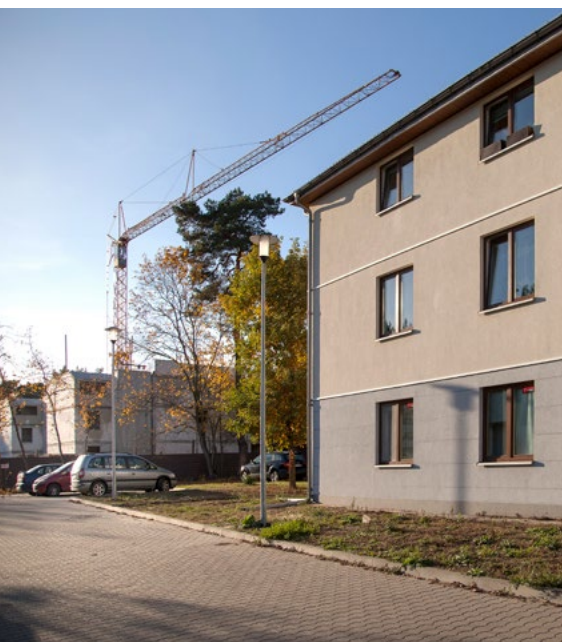
Ulica Wiązowska 95 – jeden budynek już w użytkowaniu, dwa pozostałe w budowie
