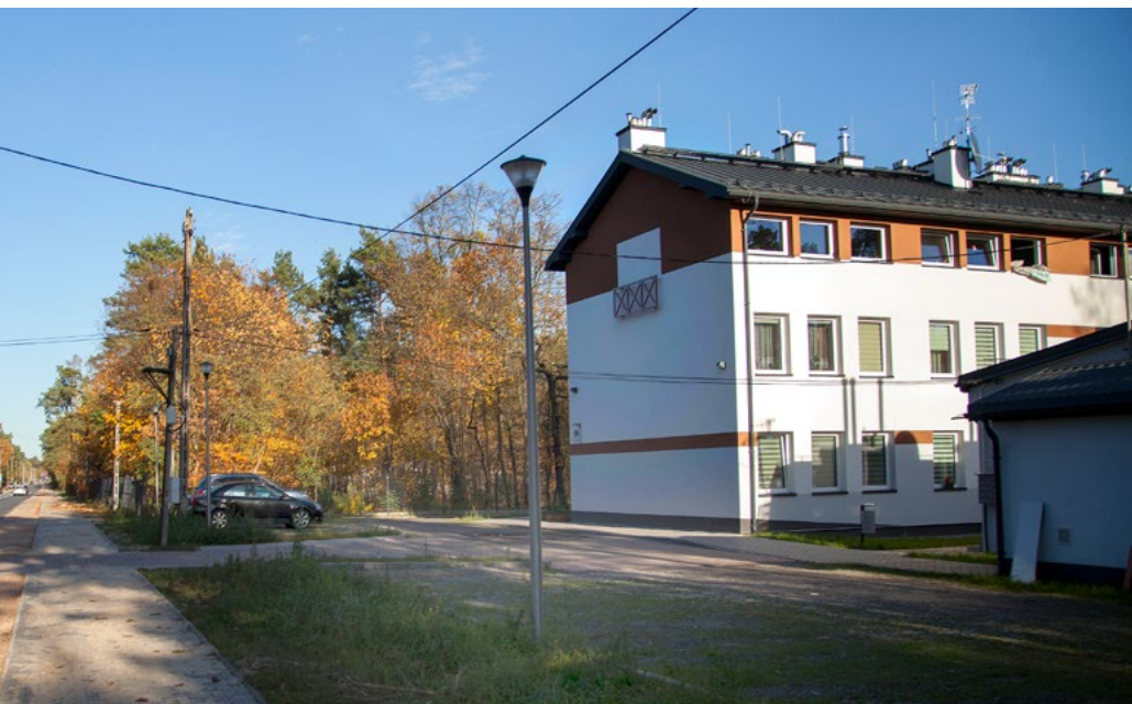
Budynek przy ulicy Wyszyńskiego 99
