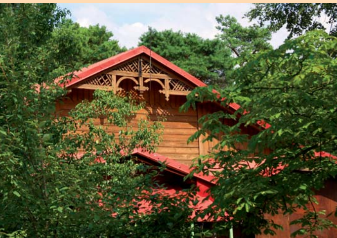
Ten częściowo wyremontowany „świdermajer” przy ulicy Poniatowskiego 8 zachwyca charakterystycznymi detalami architektonicznymi (20)
