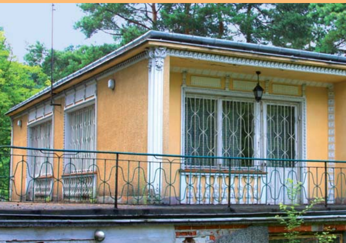
Misternie wykończony budynek przy ulicy Jodłowej 16 (21)
