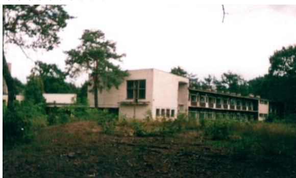
Resztki hotelu przed ostateczną rozbiórką 26
