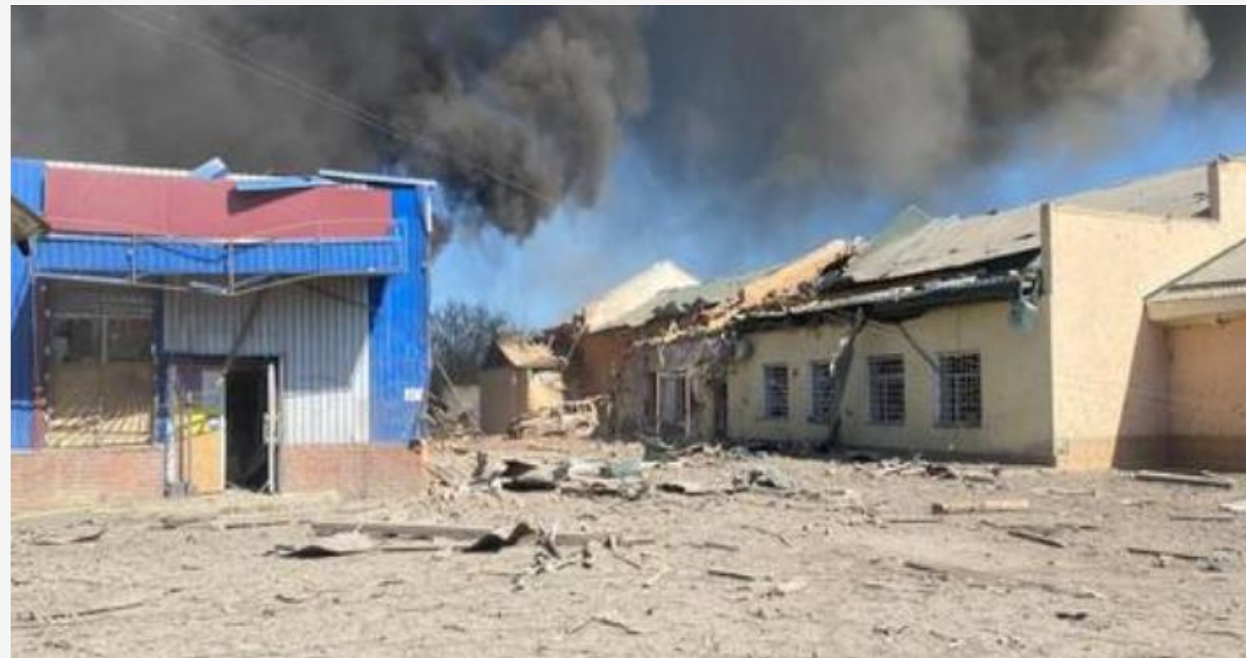
Centralna część wsi Łypce, uszkodzona w wyniku ostrzałów w kwietniu 2024 roku
