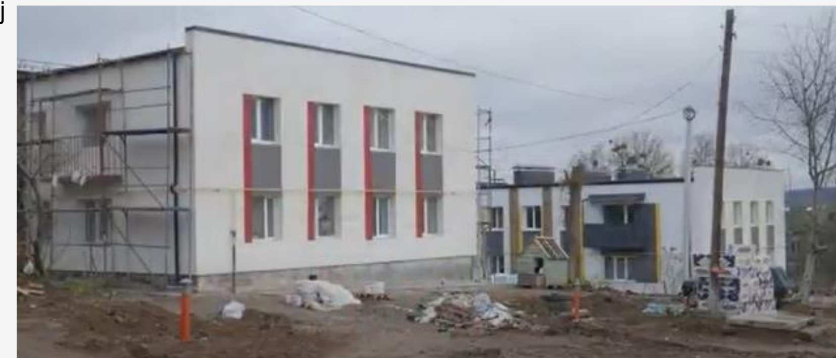
Odbudowa budynków wielorodzinnych w m. Dergacze, styczeń 2024 r.
