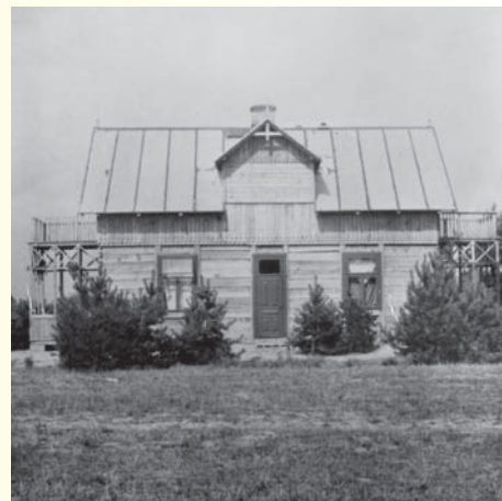
Dom Stawikowskich tuż po ukończeniu, ok. 1916
