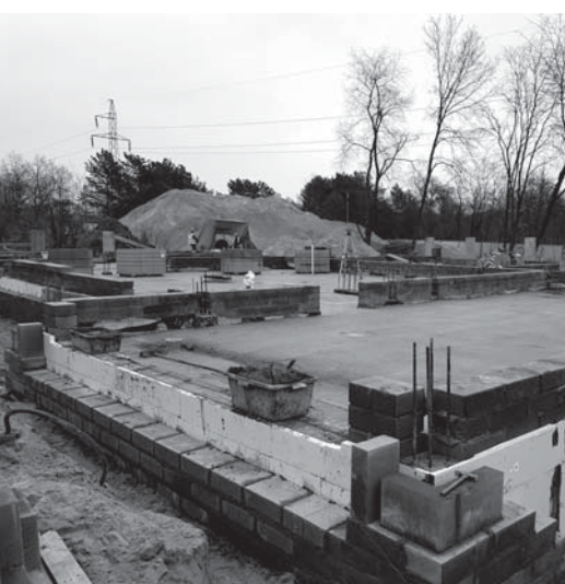
Gotowe fundamenty budynku administracyjno-socjalnego oczyszczalni, powstał pierwszy narożnik części nadziemnej
