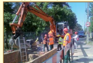
Budowa kanalizacji w ul. 11 Listopada
