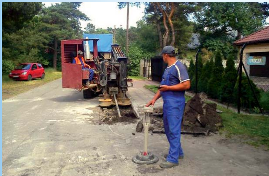
Budowa sieci wodociągowej metodą bezwykopową – czerwiec 2011 roku
