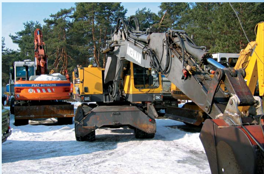
W marcu 2006 roku jeszcze leżał śnieg, ale w kwietniu praca szła już pełną parą
