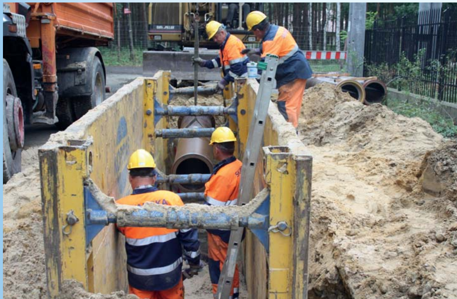
Budowa kanalizacji w ul. Budziszewskiej – rok 2011
