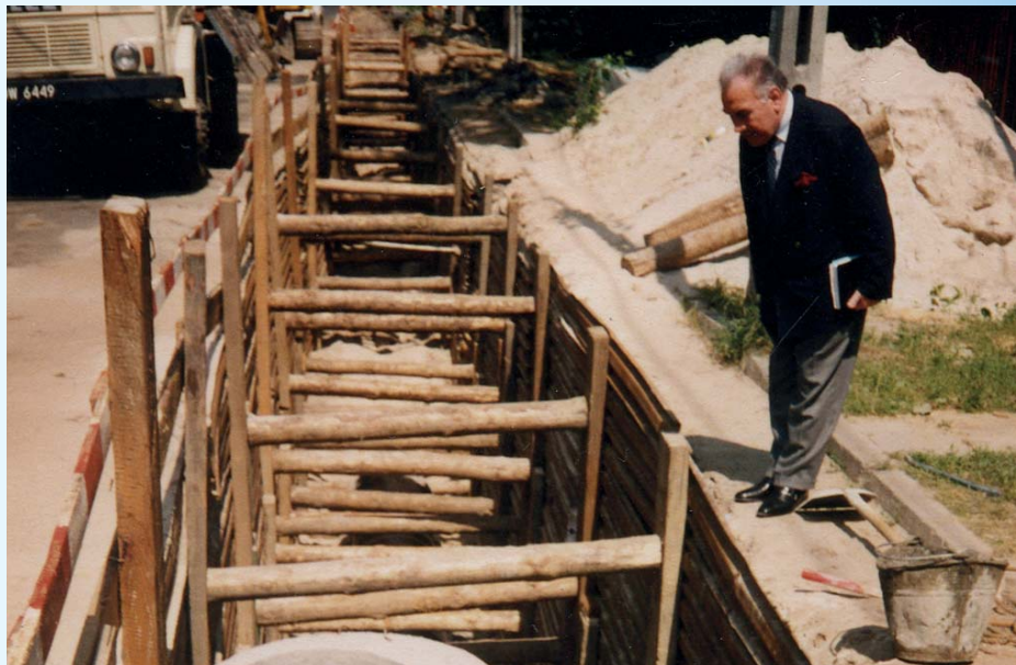
Burmistrz Zygmunt Semeniuk na pierwszym odcinku sieci kanalizacji w Józefowie – ul. Świderska róg Powstańców Warszawy
