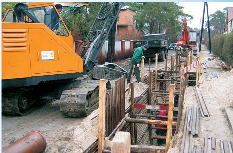
Dzięki sprzyjającej aurze roboty budowlane w 2005 roku trwały jeszcze w grudniu
