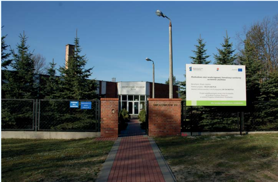
Rozbudowana Stacja Uzdatniania Wody przy ul. Drogowców 10
