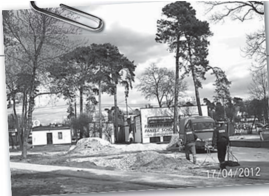
Budowa skweru przy ulicy Wyszyńskiego
