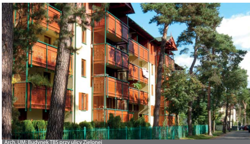
Arch. UM: Budynek TBS przy ulicy Zielonej
