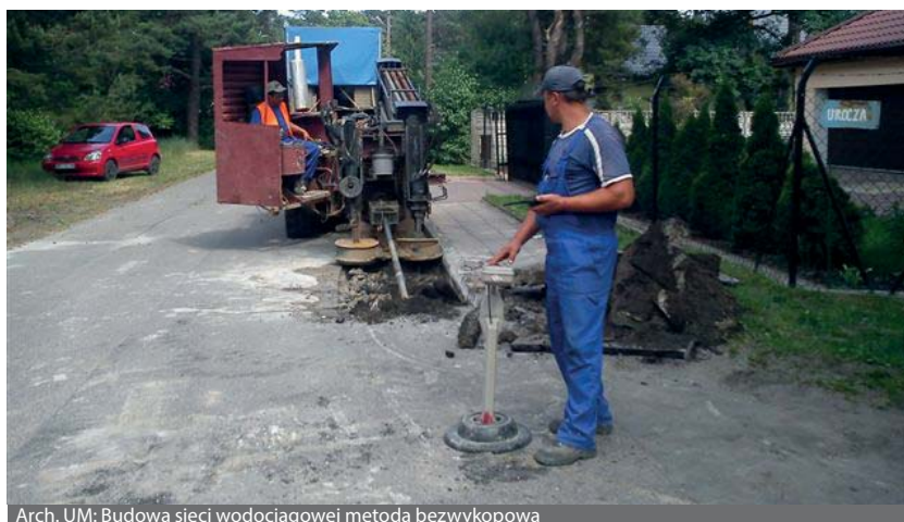
Arch. UM: Budowa sieci wodociągowej metodą bezwykopową
