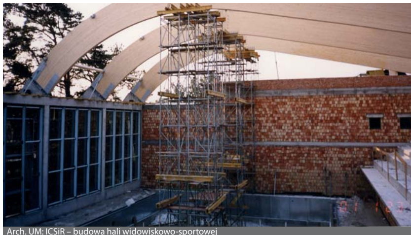
Arch. UM: ICSiR – budowa hali widowiskowo-sportowej
